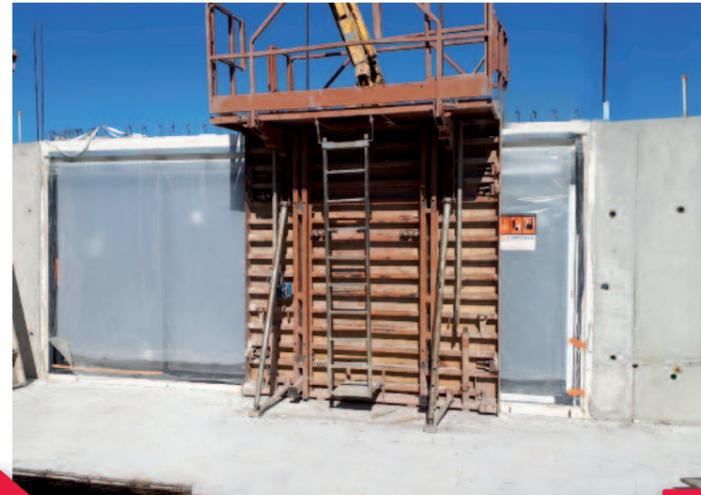
Grâce à des starts latéraux intégrés en usine, la liaison des blocs baies est optimale lors du coulage du voile béton.
