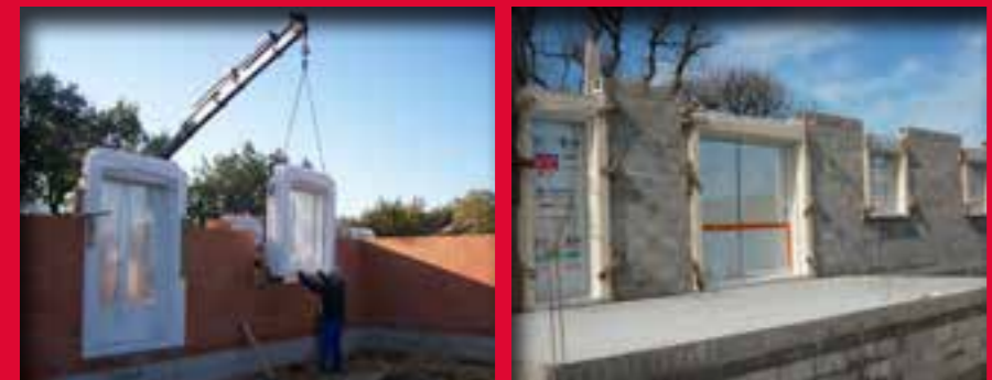
Mise à disposition Coffrage
